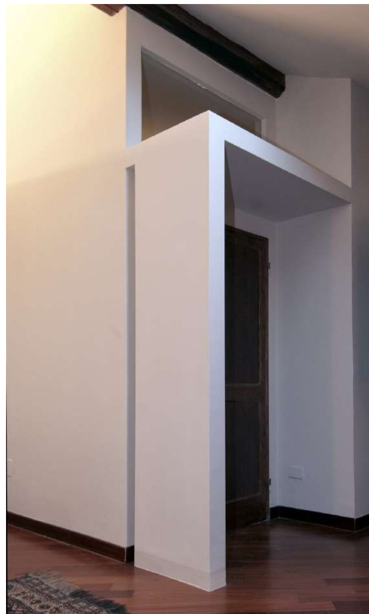
Nuovo portale a schermatura del bagno
